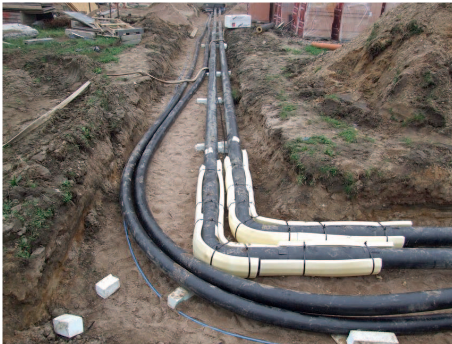
Nová teplovodní přípojka pro MEDIUMPARK PILOT 2, okrsek PS C25 ul. Pod Zámečkem
