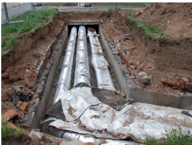
Sekundární teplovod PS B01, ul. Václavkova 1612-1614 – původní potrubí
