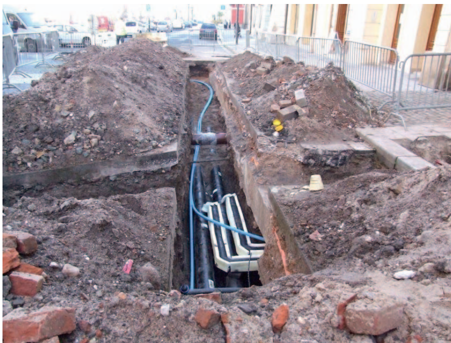
Sekundární teplovod – přípojka topné vody pro čp.42 Karla Tomana
