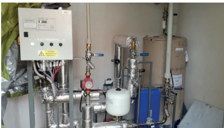
Technologie DPS - Bytový dům „C“, Nové Farářství
