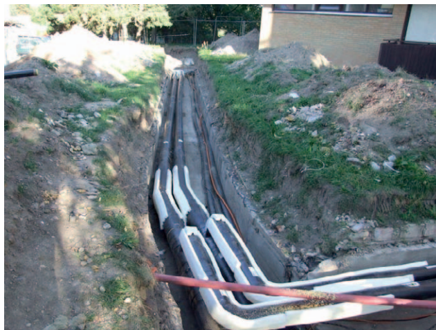
Sekundární teplovod PS C42 ul. Milady Horákové 417-421 - 1. etapa – nové potrubí
