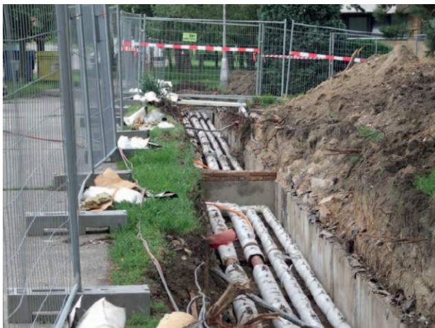
Sekundární teplovod PS C42 ul. Milady Horákové 417-421 - 1. etapa – původní potrubí
