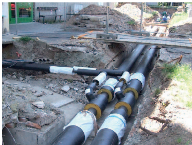
Sekundární teplovod PS B0,1 ul. Václavkova 1612-1614 – nové potrubí
